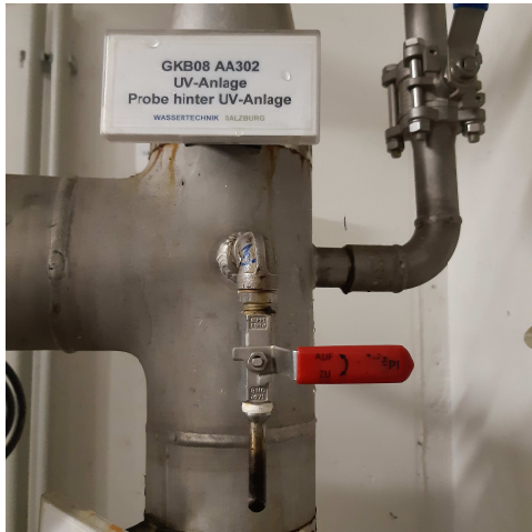
Abb. 9: PNST-nach UV-Desinfektion
