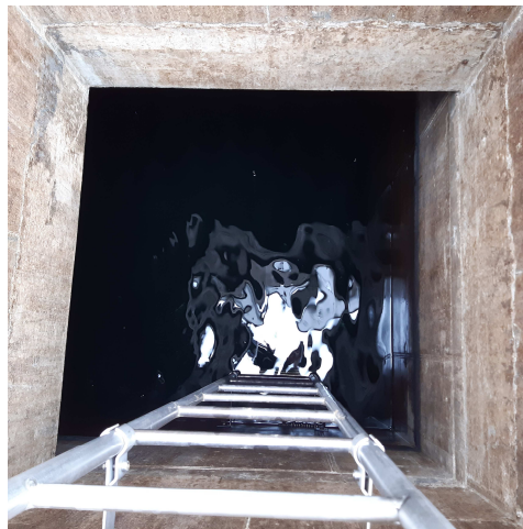
Abb. 6: Innenansicht in TB Hadersdorf
