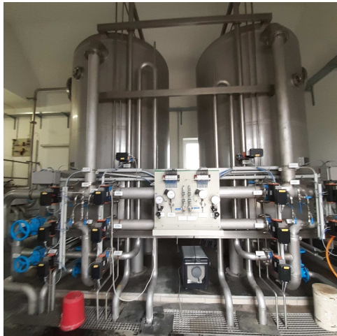
Abb. 3: Enteisung-/ Entmanganungsanlage
