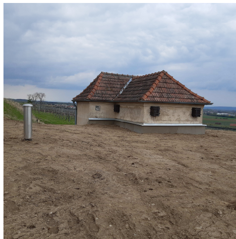
Abb 12: Überdeckung und Entlüftungspilze
