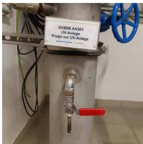
Abb. 8: PNST-vor UV-Desinfektion
