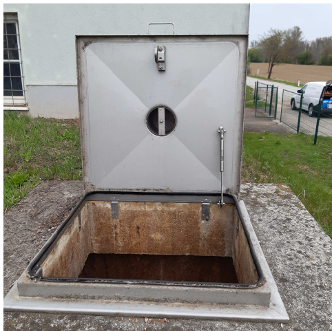
Abb. 5: Einstieg in TB Hadersdorf
